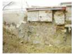
開削による地盤状況確認
